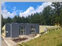
7 Přístavba dvorního traktu laboratoří - MN...
